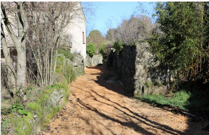
Les travaux de réhabilitation ont été réalisés par l'entreprise SOUCHON tels que prévus dans l'étude. Un fossé a été creusé et des buses permettant de récupérer les eaux pluviales, ont été installés en bordure de la chaussée, qui a été gravillonnée. Un dispositif de collecte des eaux venant du cimetière a été construit. Montant de l'investissement : **23.247,52 € TTC**, subvention obtenue dans le cadre des amendes de police : **15.176,40 €**
